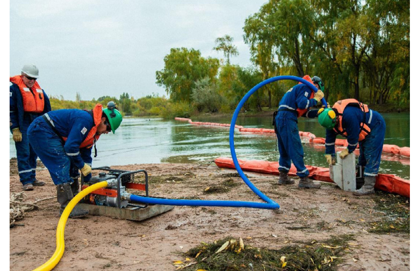
La recolección se hizo mediante bombas para su trasvase a tanques móviles
