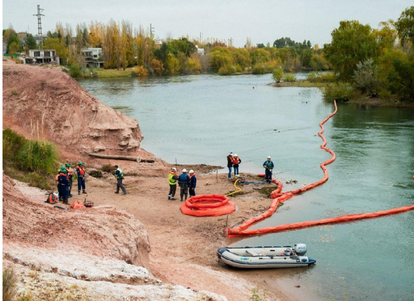
Despliegue de barreras en zona de control
